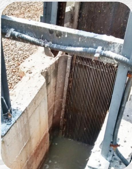
As unidades combinadas são fornecidas de modo a serem instaladas diretamente sobre uma superfície de concreto. Podem também dispor de uma caixa de "by pass" provida de um gradeamento manual para emergências ou manutenção, além do acesso rápido para o caminhão limpa fossa.
